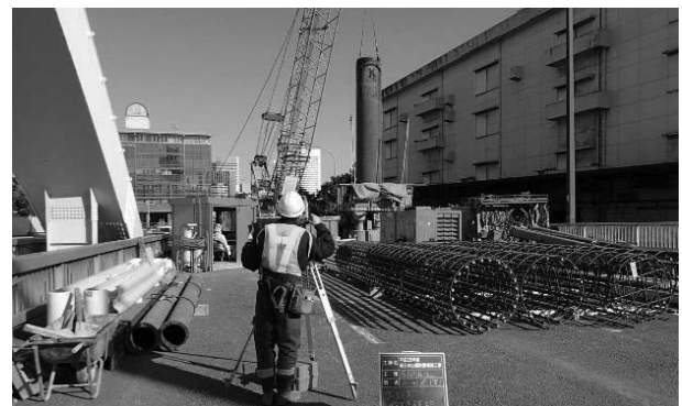
図-12 ケーシング鉛直度確認
