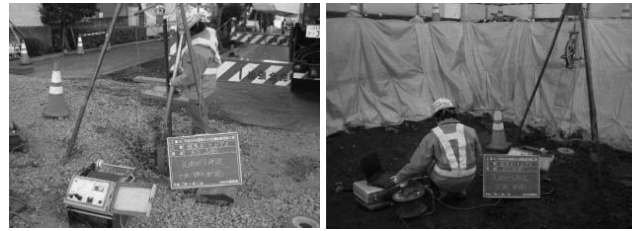
図-8 センサー挿入 図-9 孔曲がり測定
