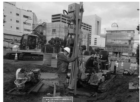
図-5 ボーリング施工状況
