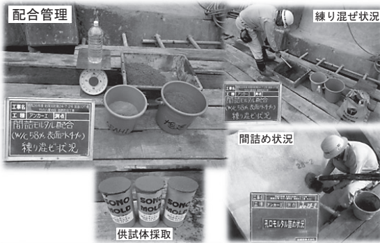
図-9 間詰めモルタル配合管理
