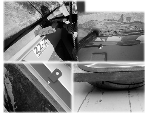
図-11 設置面の空隙処理
