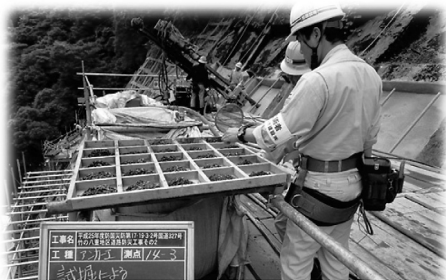
図-5 試掘調査状況
