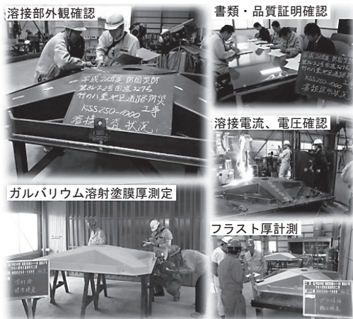
図-10 鋼製受圧板工場検査
