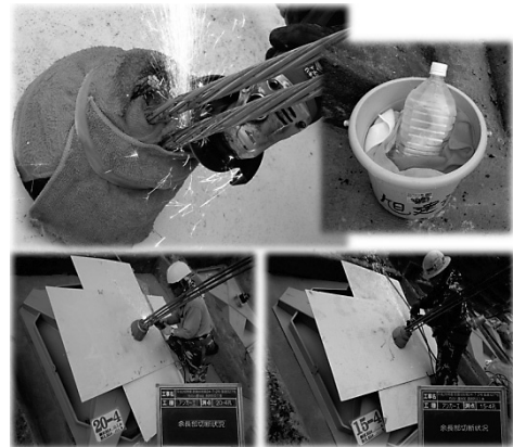
図-12 鋼線切断時の熱、火花対策
