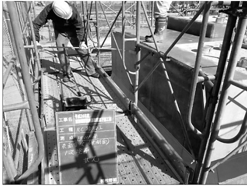
図-4 表面保護工施工状況
