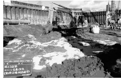
図-15 表層改良状況
