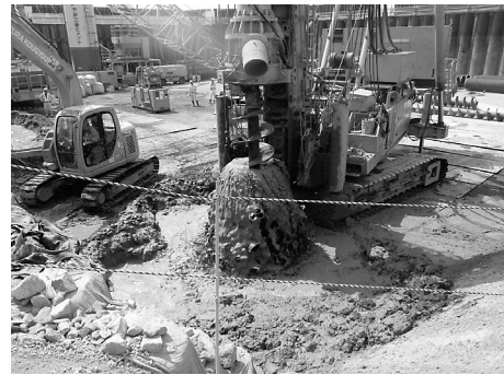
図-6 被圧地下水噴出状況
