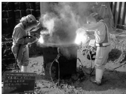
図-14 継ぎ溶接作業状況
