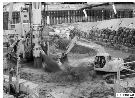
図-7 泥水拡散状況
