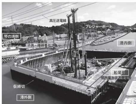
図-5 鋼管杭中掘施工状況
