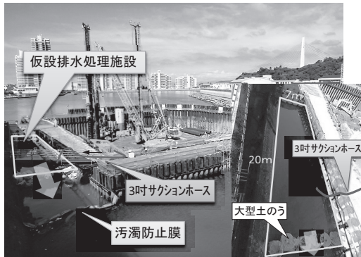
図-13 仮設排水施設状況
