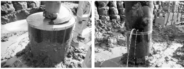
図-8 被圧地下水溢れ出し状況
