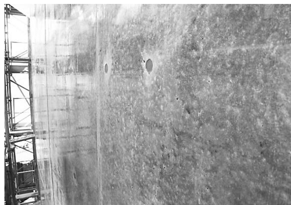
図-10 ガラス質が形成されたコンクリート表面
