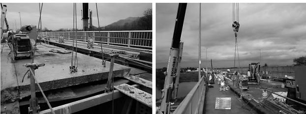
図-6 床版2次切断・吊上げ（床版・地覆）
