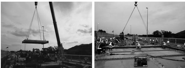
図-11 床版撤去・新設状況
