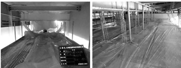
図-10 吊足場シート養生状況(中段・下段)
