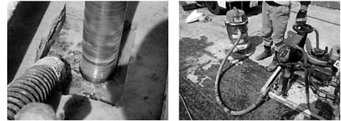
図-7 濁水採取状況（吊孔削孔）
