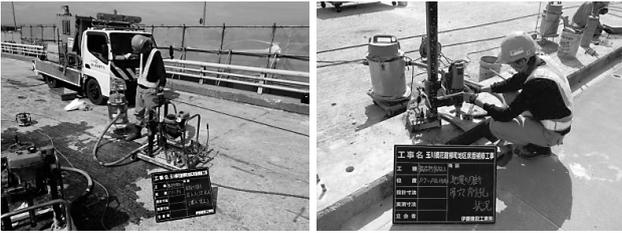
図-4 吊孔削孔（床版・地覆）
