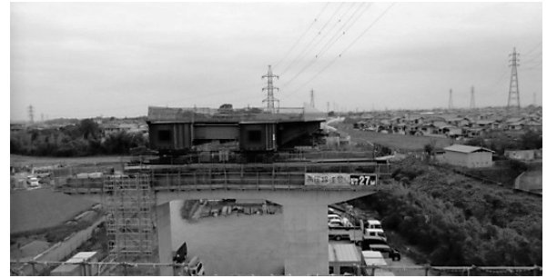
図-13 旋回横取り施工前
