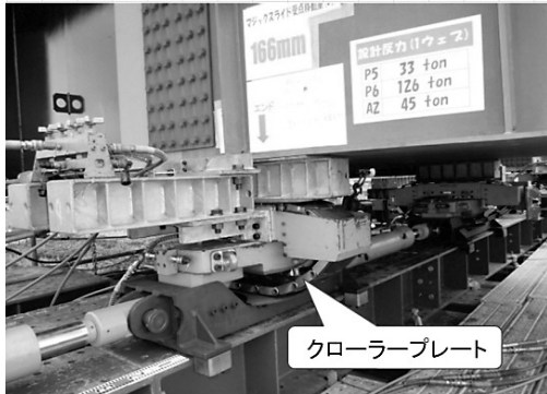
図-11 Cap. 200tマジックスライド（P6橋脚）
