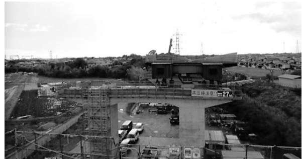
図-14 旋回横取り完了
