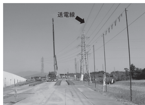
図-2 送出しヤード全景
