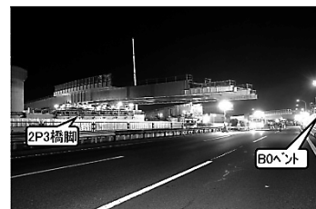
図-11 送り出し状況と完了風景
