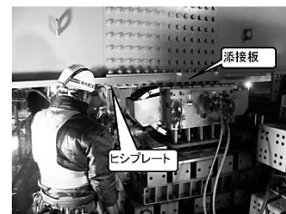
図-10 段差吸収プレート
