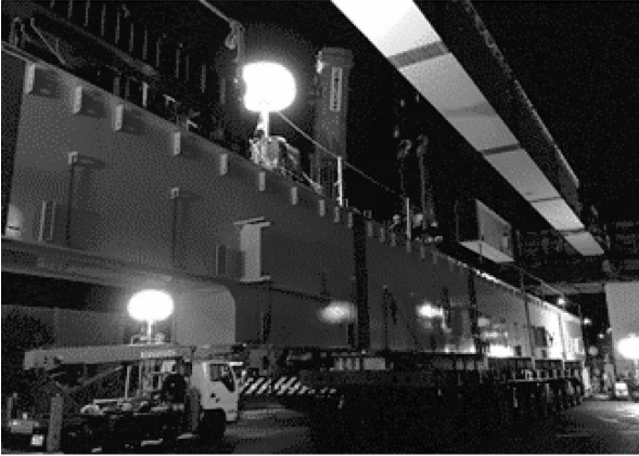
図-8 地組桁大ブロック運搬状況
