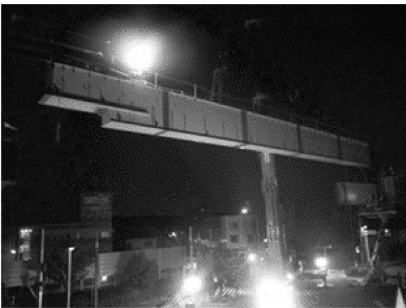
図-9 大ブロック架設状況
