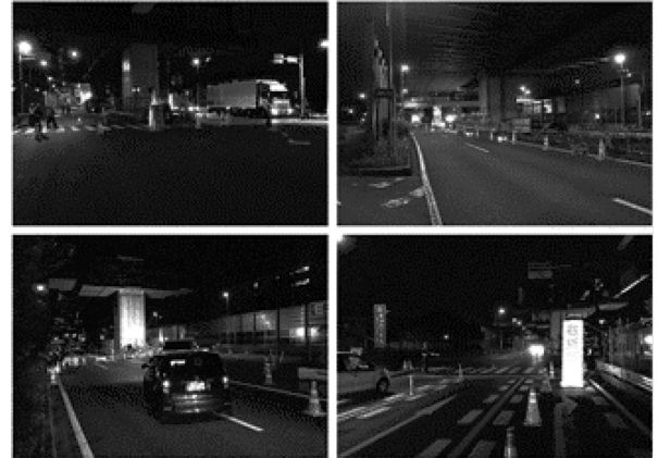
図-10 国道夜間規制状況
