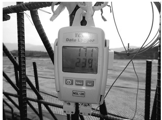
図-6 データロガーでの測定状況
