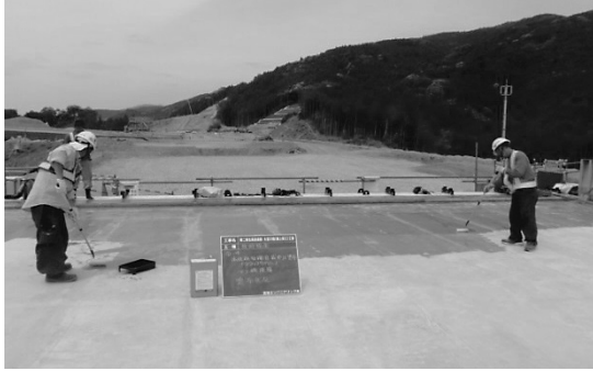
図-7 クラックセイバー塗布状況
