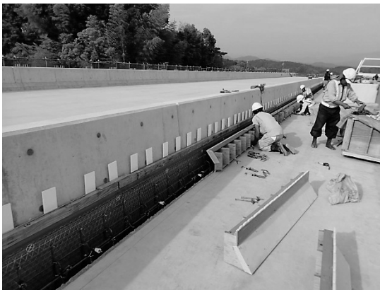
図-4 下り線地覆外型枠組立状況 (奥側が上り線・中央分離帯完了)
