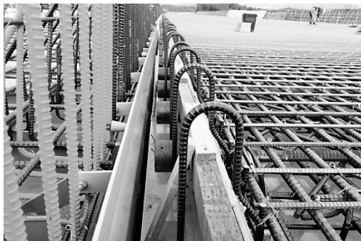
図-2 上下線の隙間（左側が合成床版）
