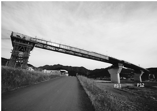
図-10 送り出し架設状況
