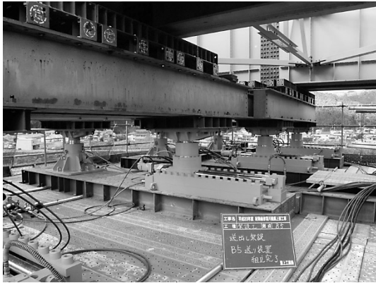
図-8 「送り装置」の組立て状況
