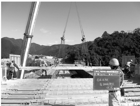
図-9 合成床版パネルの架設状況
