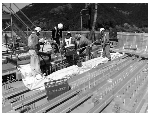
図-6 巻立てコンクリート打設状況
