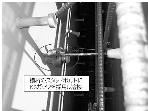
図-7 型枠セパレータと止め金具への接合
