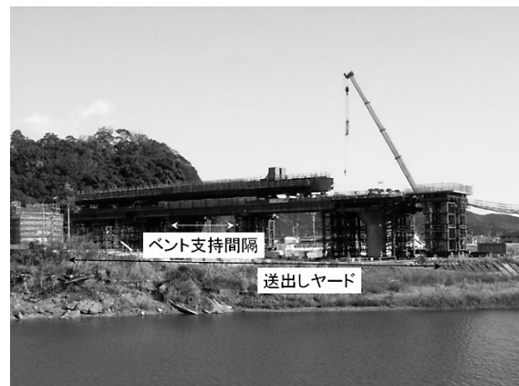
図-3 ベント支持間隔と送り出しヤード
