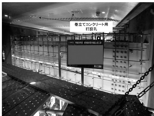
図-5 巻立てコンクリート用打設孔
