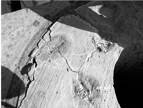
図-8 鋼管内側静的破砕状況
