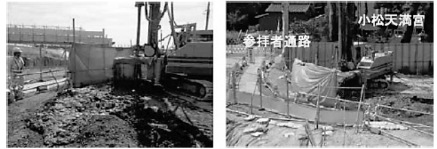
図-8 飛散防止対策状況
