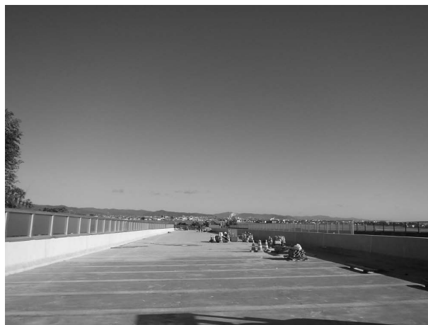
図-8 壁高欄施工完了（起点方より）
