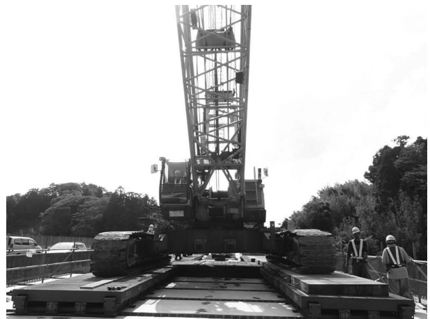
図-4 床版上補強状況(2)
