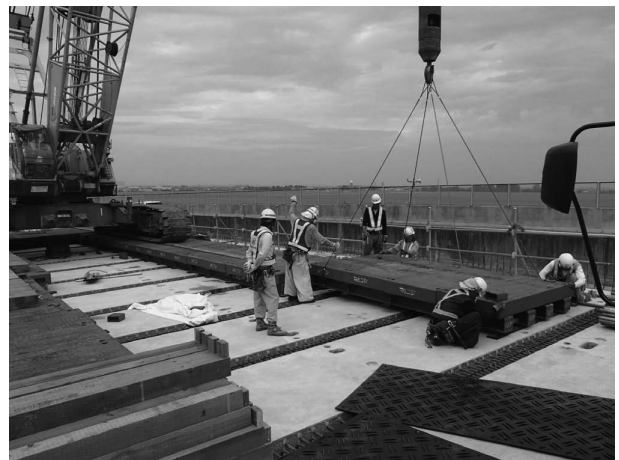
図-3 床版上補強状況(1)
