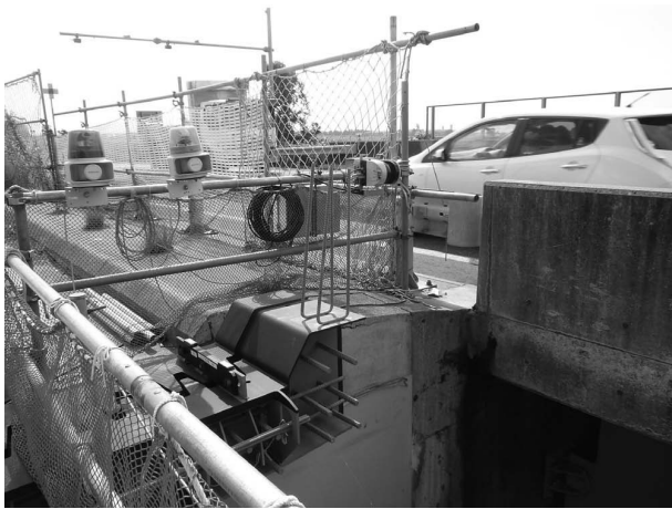
図-2 レーザースキャナー設置状況
