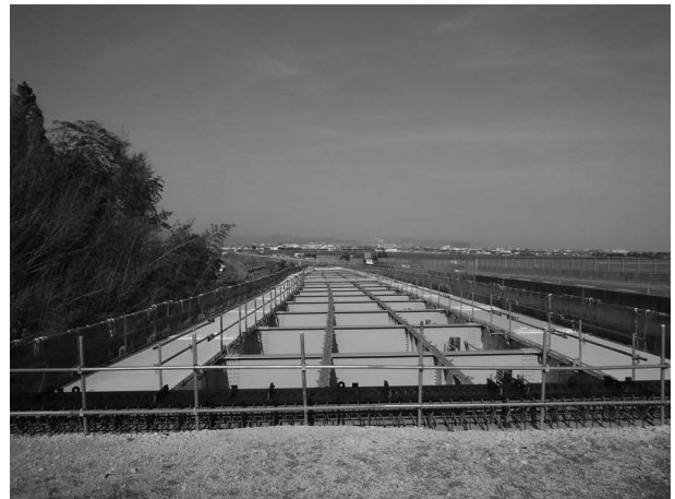
図-1 施工前全景
