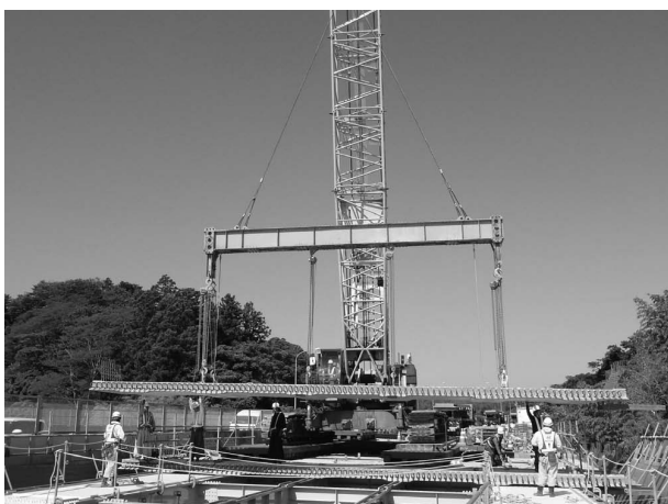
図-5 プレキャスト部材架設状況
