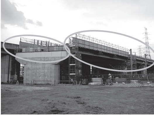
図-8 線路上の防護工
