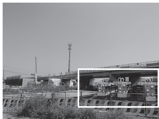
図-2 主桁仮置状況
