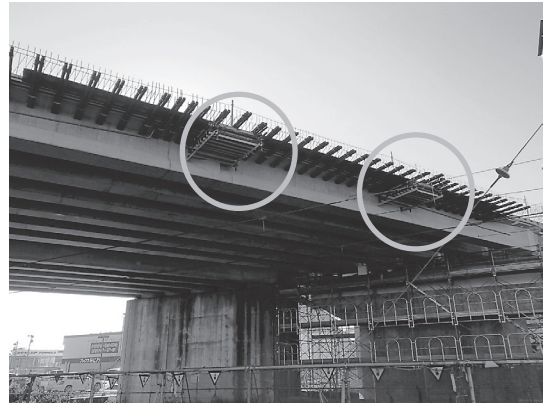
図-3 緊張、グラウト用足場組立
