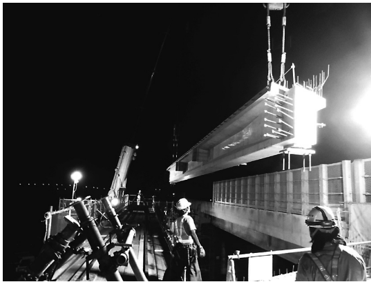
図-5 主桁架設状況
