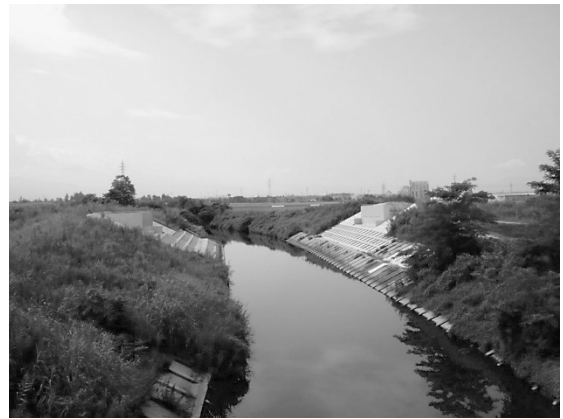
図-1 施工前状況
