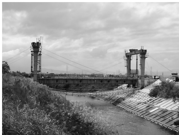
図-2 門構組立全景
