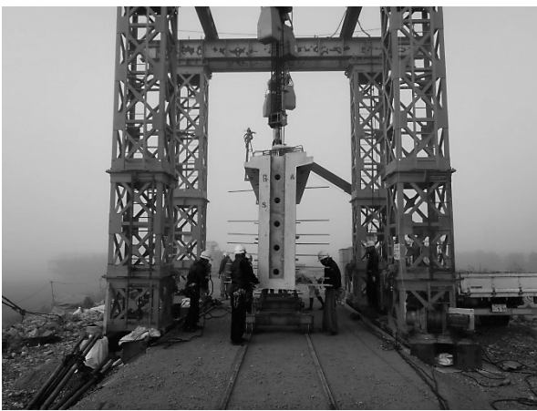
図-4 取りおろし門構装置
