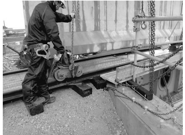
図-5 ガーダーとレールの接続部
