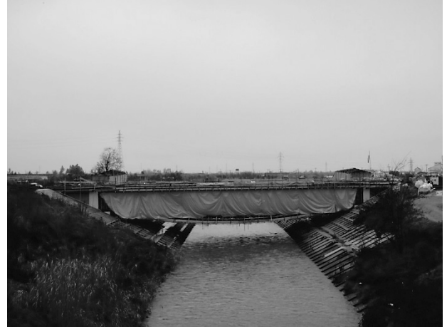
図-8 床版養生状況
