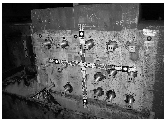
図-3 アンカーボルト写真計測
