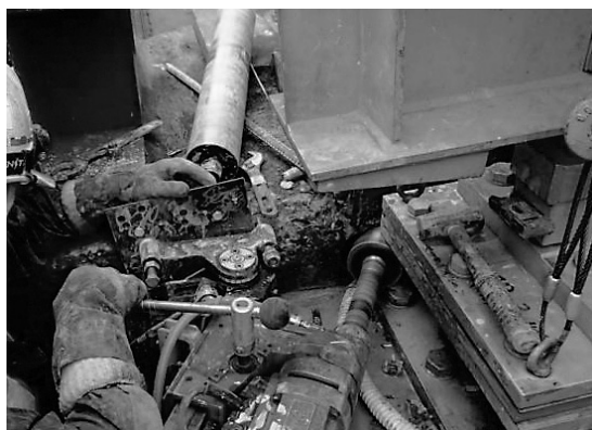
図-2 支承台座ハツリ作業(コア削孔)
