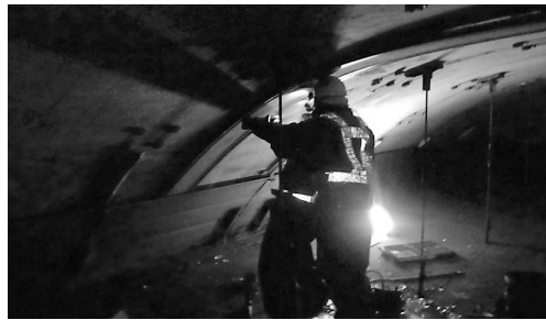
図-2 線導水設置状況
