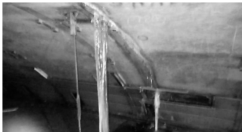
図-1 漏水の凍結状況
