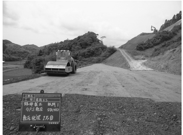
図-3 GNSS 締め固め
