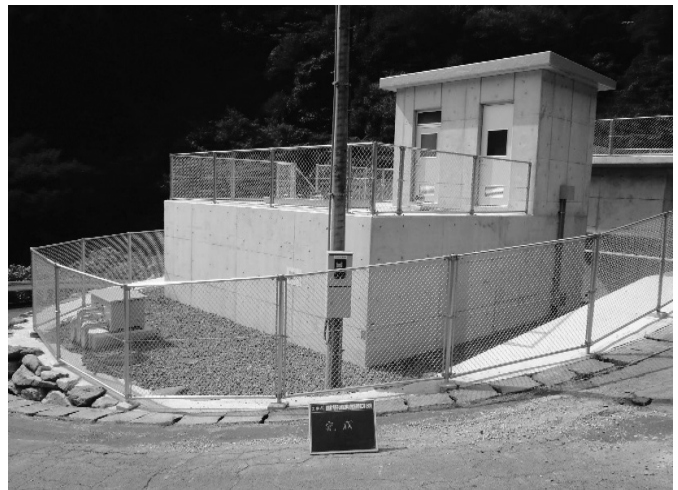
図-1 配水池完成写真
