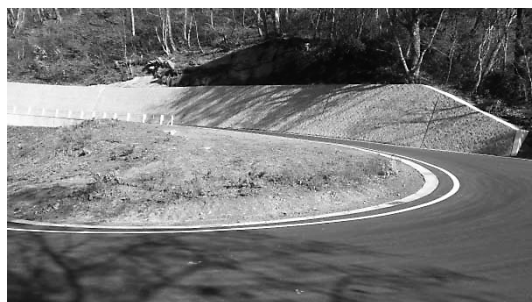
図-6 現場完成写真
