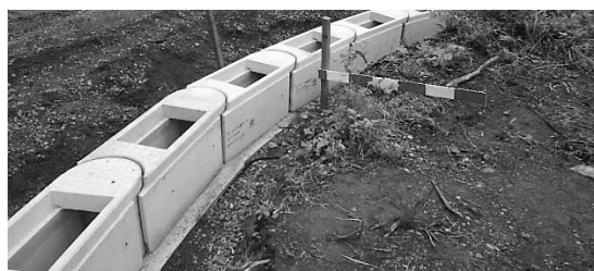
図-5 現場施工状況写真
