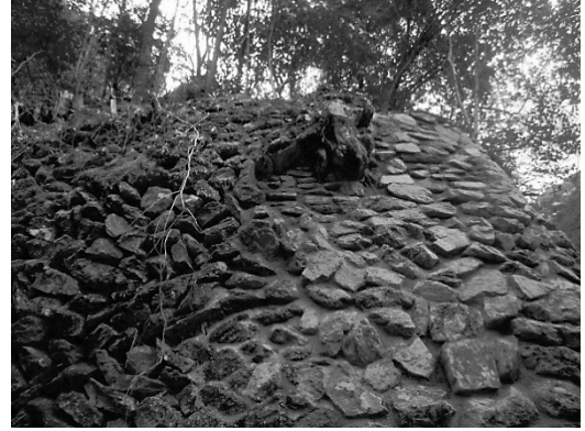
図-4 石積み完了
