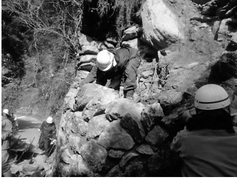
図-3 石積み状況
