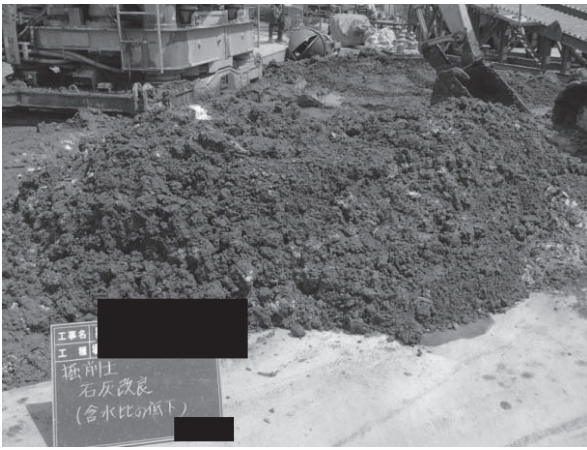
図-3 掘削土の石灰改良
