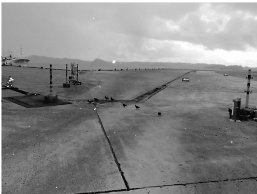
図-1 施工前全景
