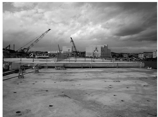
図-4 現在の現場状況
