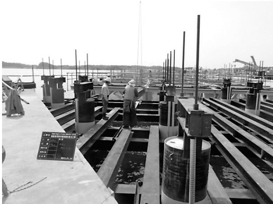
図-2 吊り支保工組立
