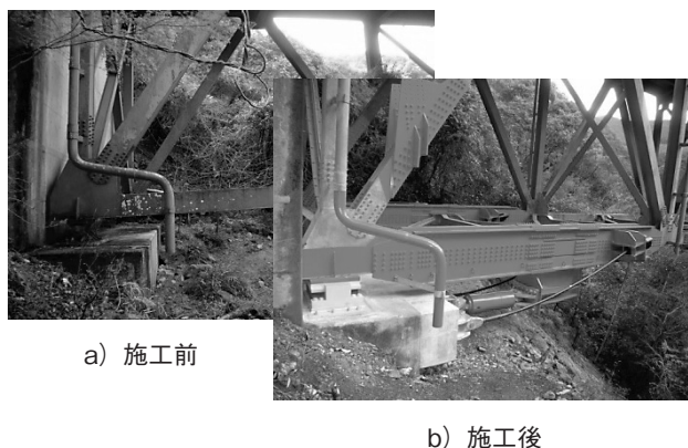
図-4 支承取替施工前・後
