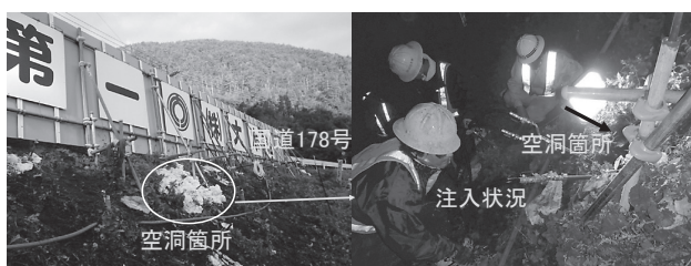
図-4 空洞処理状況
