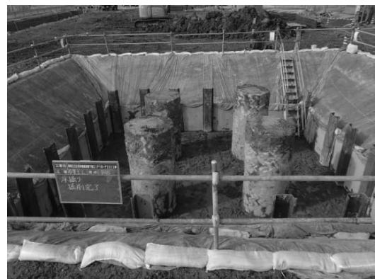
図-5 法面の浸食・崩壊防止対策写真
