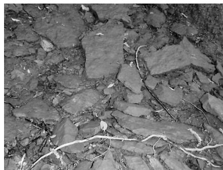
図-4 剥離落下した岩盤
