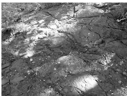
図-3 亀裂が入り土砂化しやすい泥岩
