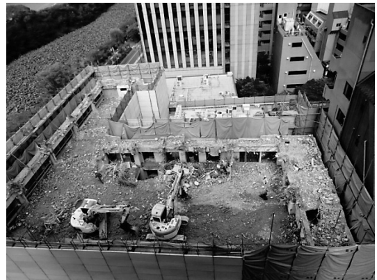
図-1 階上解体状況
