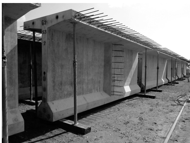
図-2 主桁仮置き状況
