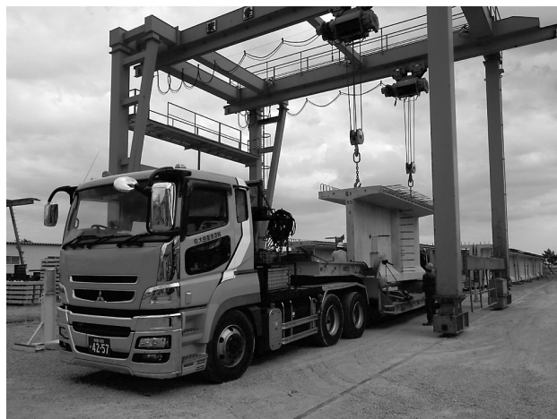
図-3 主桁出荷状況
