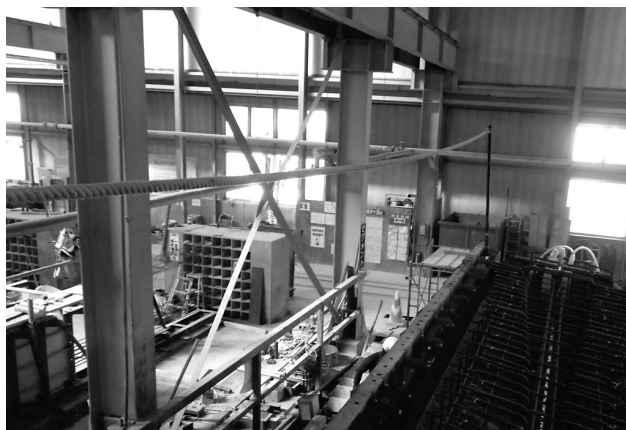
図-1 親綱、手すり設置状況
