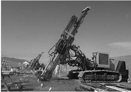
図-3 地盤改良工 斜め削孔状況
