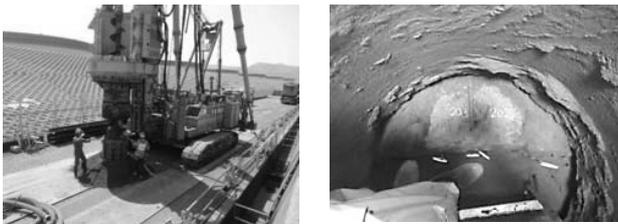
図-4 杭打ち機を使用した試掘状況
