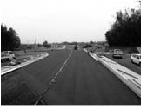
図-3 クラック抑制シート施工状況
