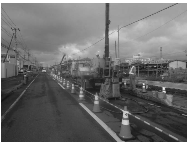
図-1 路線補足薬液注入状況
