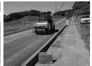
図-7 攪拌後転圧
