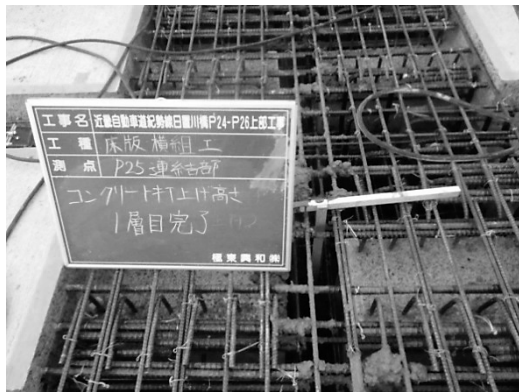
図-4 打ち上げ高さの管理
