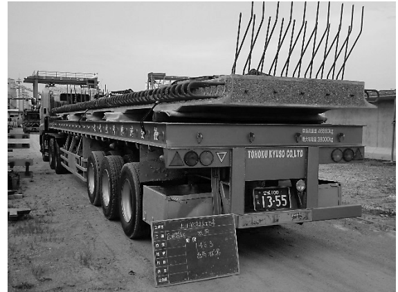
図-3 PC床版の出荷状況
