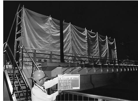
図-2 防音シート設置状況写真
