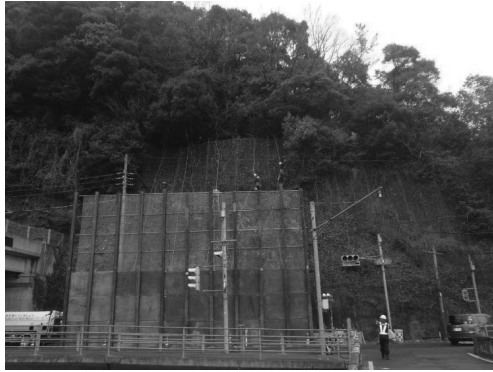
図-3 防護柵設置後伐採状況
