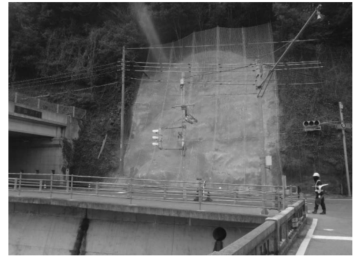
図-4 施工完了全景
