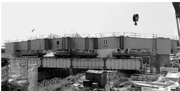
図-4 横梁架設完了
