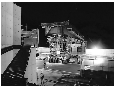
図-2 多軸台車による送り出し架設
