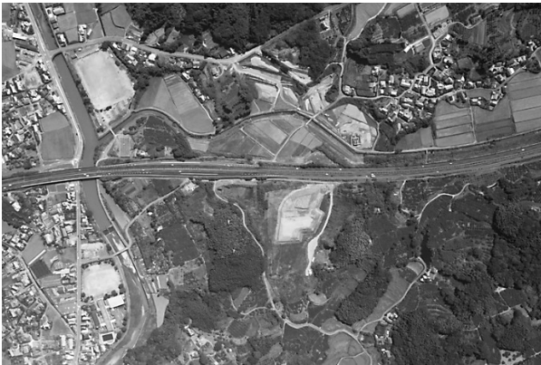
図-1 着工前全景
