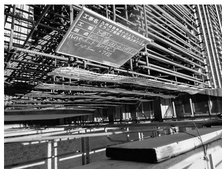
図-4 ハイパーネット設置状況（剛結部側面）
