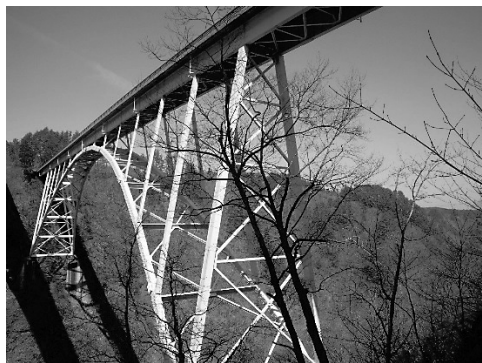
図-1 槇木沢橋全景(補修前)
