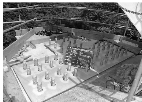
図-5 補強材(プレート)設置完了
