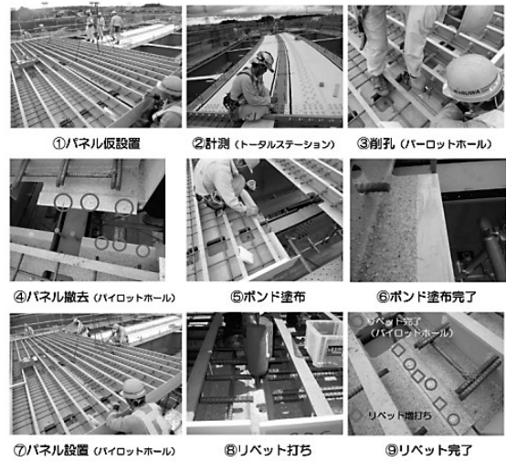
図-5 FRPパネル設置状況
