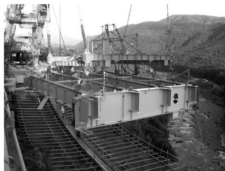
図-6 床組み部材架設状況
