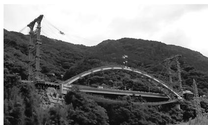
図-5 上弦材架設完了状況
