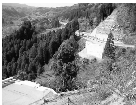
図-2 急峻な斜面を有する現場状況
