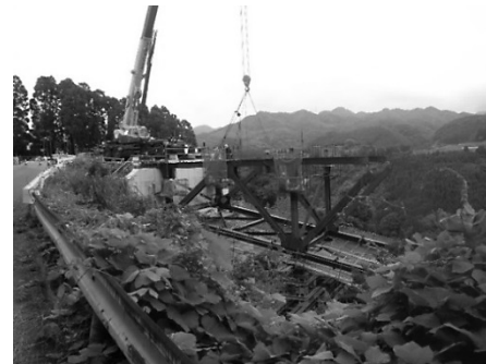
図-4 トラッククレーン架設
