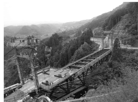
図-5 ケーブルクレーン架設
