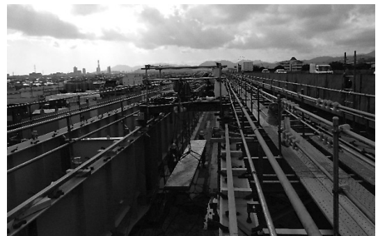
図-5 桁間吊り設備
