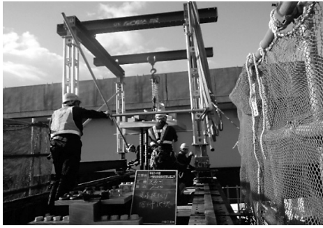
図-2 支承の移動設備
