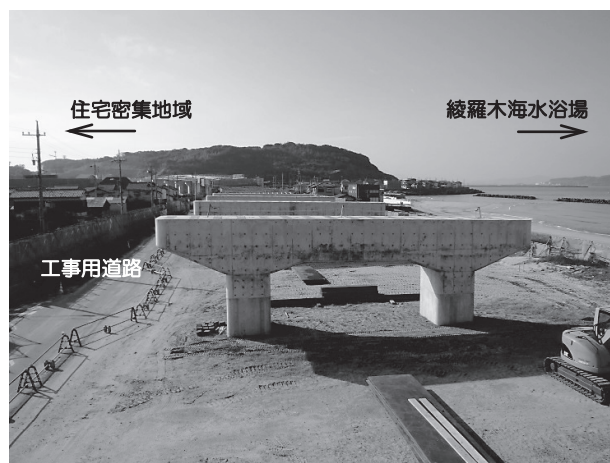
図-1 着工前現場状況
