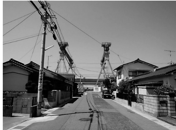
図-3 住宅密集地域での架設
