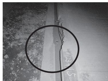
図-1 SPによる側溝の破損例
