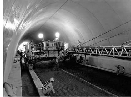
図-5 SPでの施工状況
