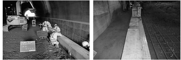
図-4 側溝施工状況及び養生状況
