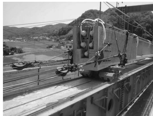
図-5 主桁引き出し状況
