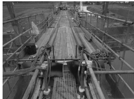
図-6 前方滑車設置状況
