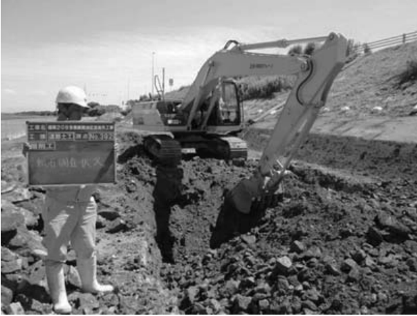
図-1 支障物除去状況
