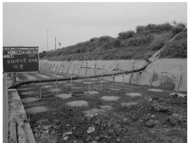
図-3 供用道路排水状況（仮橋と波状管）
