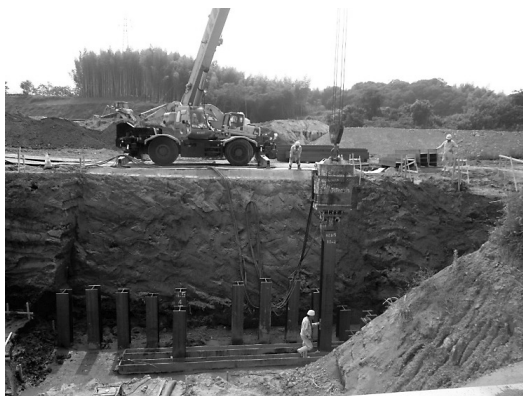
図-3 H鋼打設状況
