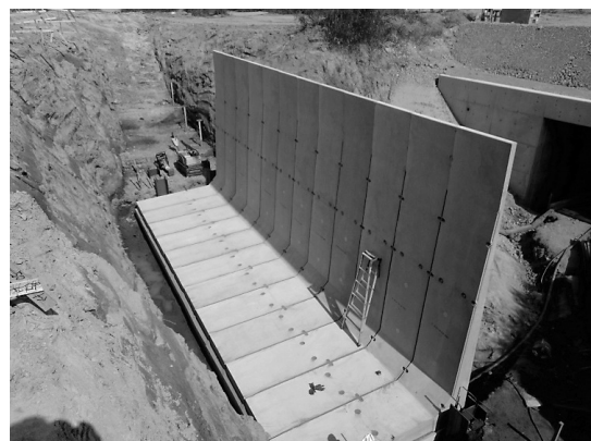
図-4 L型据付完了
